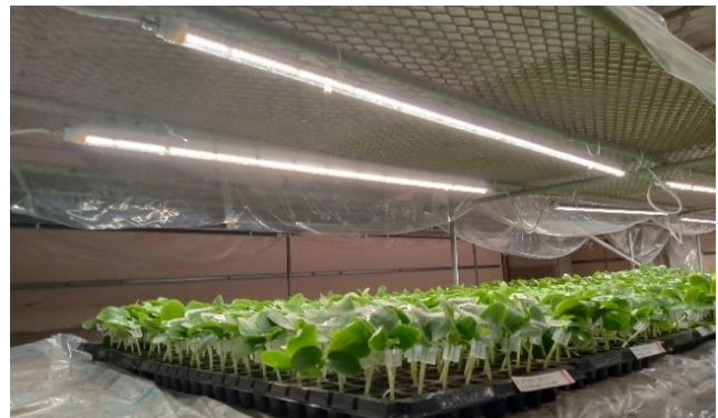
■LED両側にコードがあり直列に連結する方式です。施設園芸の補光用として多く使われるタイプです。
