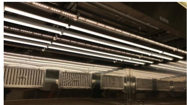
■並列タイプは多段式のラック設置に適した配線タイプです。
